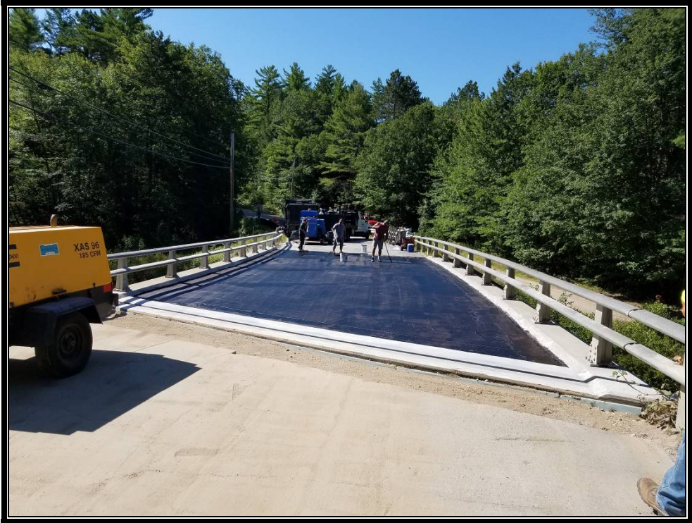
Photo 2: Installing primer coat.
