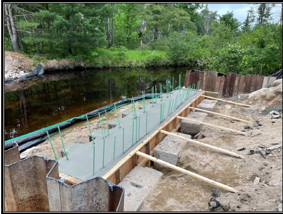
Photo 2: East pilecap pour complete.
